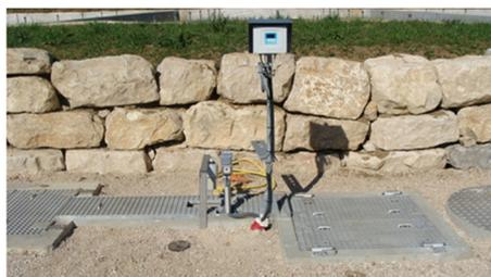
Le fonctionnement est totalement automatisé, une surveillance hebdomadaire a lieu pour l'évacuation des déchets indésirables collectés par le dégrilleur et l'entretien des abords. Le faucardage des roseaux est réalisé une fois par an.
